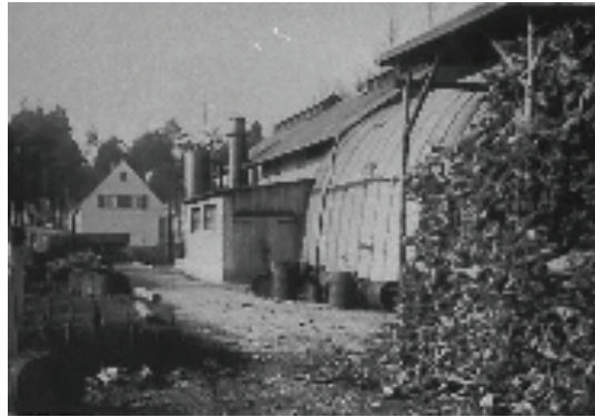
Verschmelungsanlage an der Dr.-Franken-Straße
